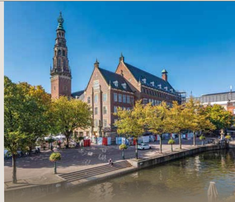
Het historische stadhuis middenin in de binnenstad van Leiden ondergaat een ingrijpende renovatie en krijgt een wko-systeem.
